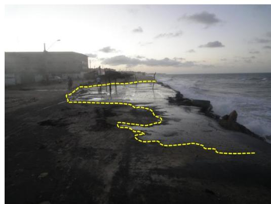
**Figura 7** – Registro fotográfico do regime de galgamento do setor S3 de monitoramento da Praia do Icaraí, o traçado em amarelo destaca o escoamento de água pela via costeira no período 07 a 12/09/2014.
